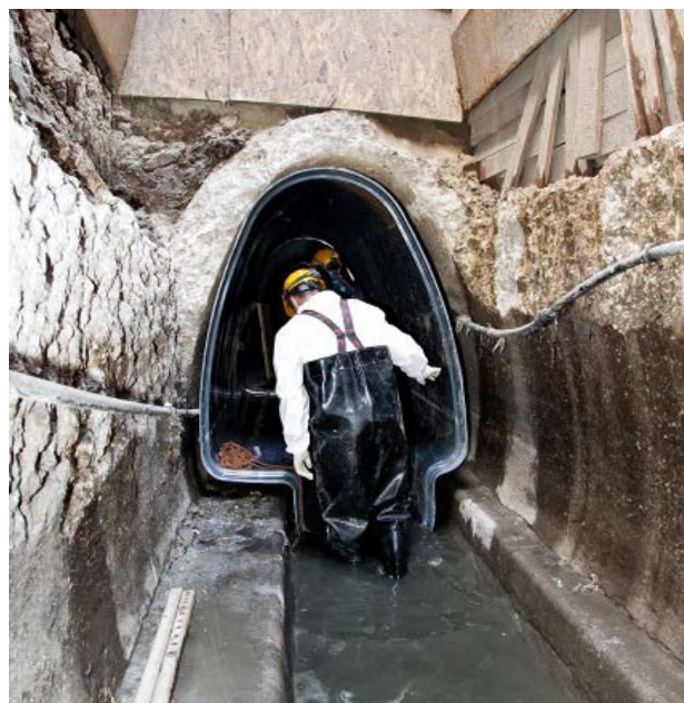
Fot. 1, 2. Naprawy wykonywane z użyciem paneli z żywicy syntetycznych wzmocnionych włóknem szklanym [GRP, TWS]
