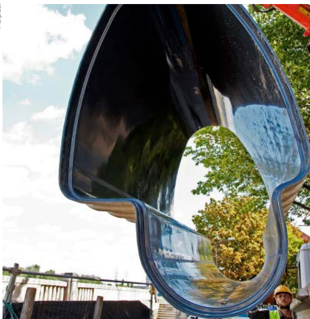
Fot. 1, 2. Naprawy wykonywane z użyciem paneli z żywicy syntetycznych wzmocnionych włóknem szklanym [GRP, TWS]
